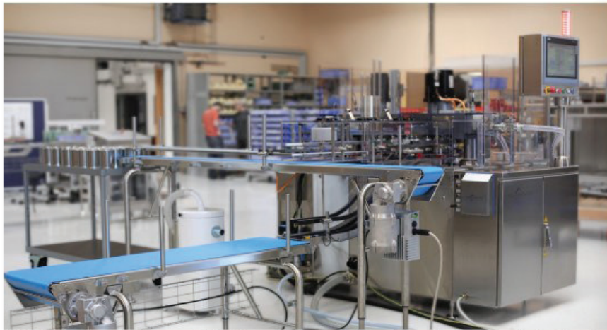
An den Förderbändern sorgen Glattmotoren inkl. aufgebautem Nordac Base Frequenzumrichter von Nord Drivesystems für den reibungslosen Dosentransport. (Bilder: Nord)
